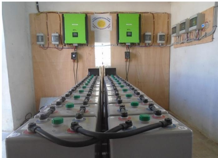
Le local technique de la centrale, avec les 24 cellules de batteries de 2 Volts, et les deux gros onduleurs-chargeurs de 5 kiloWatts
