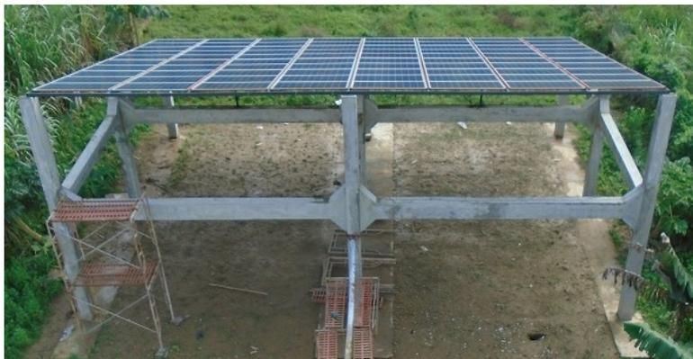
La structure supportant les 80 panneaux de 270 Watts crête, orientée au Nord
