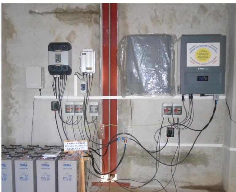
La centrale électro-solaire : les batteries, les chargeurs solaires et l'onduleur triphasé de 9kW avec, sous plastique, un onduleur de rechange, au cas où...
