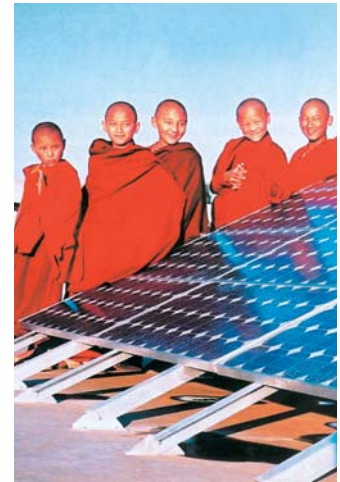
Impianto fotovoltaico al monastero Kopan di Kathmandu in Nepal (Foto Lotus Energy Pvt., Ltd.)
