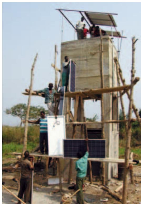
stations d'adduction électro-solaires d'IAS. Le modèle, simple, contient 27 000 litres, soit environ quatre jours, en moyenne annuelle, d'une confortable autonomie aux familles en cas de défaut d'ensoleillement.
